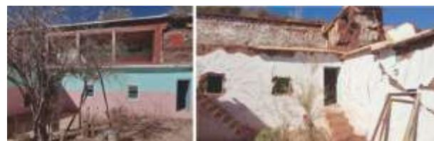
Figure 9: Vues montrant les patios partiellement effondrés dans les habitations de Tirknit après le séisme de 2023
